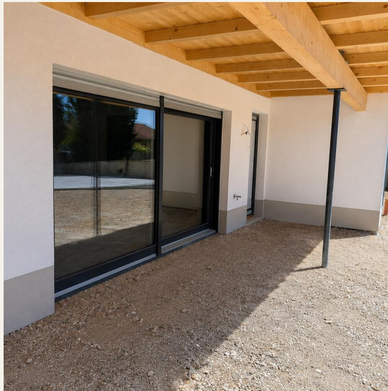
Außenansicht überdachte Südterrasse
