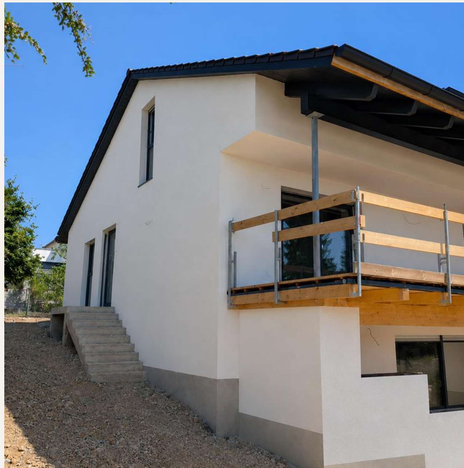
Außenansicht zum Hauseingang
