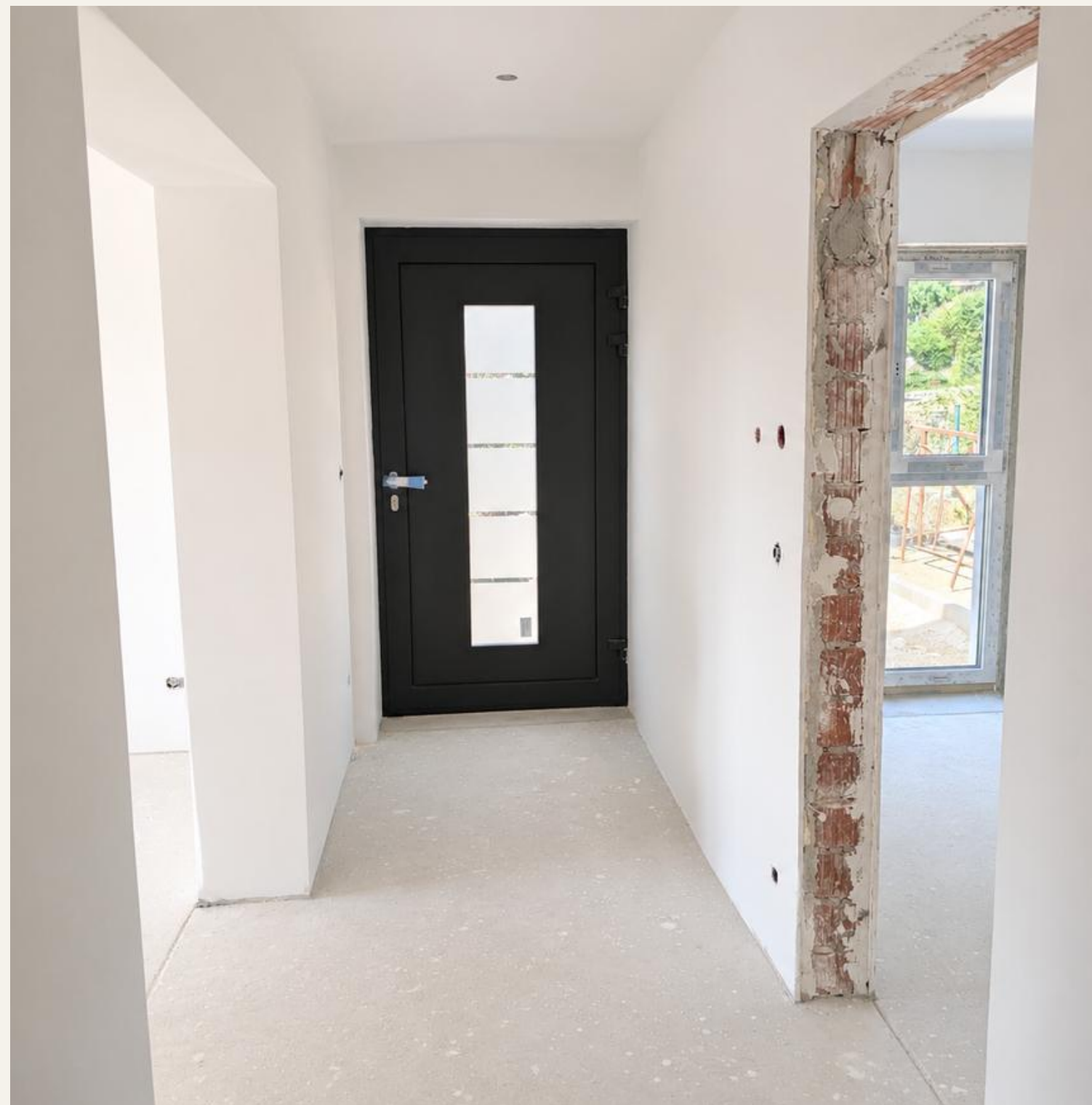
Hauseingang (links Wohnzimmer, rechts Küche und Essbereich)
