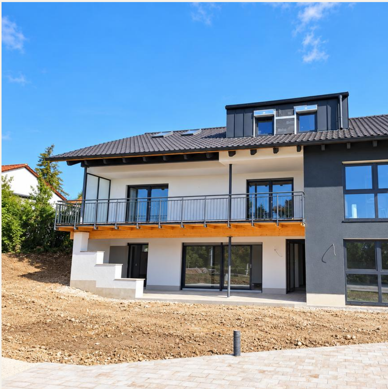
Außenansicht - großzügig, überdachter Balkon
